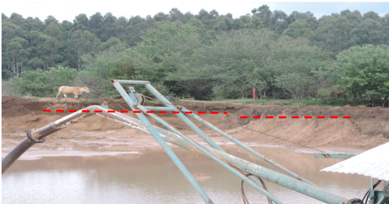
Foto 11- Prosseguido na vistoria. Em foco: área da cava apresentada à perícia. Notar que nas barrancas (taludes) divisa horizonte com afloramento superficial de minério (areia). Acima da linha, horizonte orgânico. Abaixo desta linha, jazida natural.
