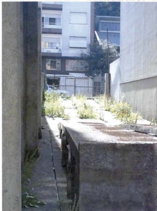
FOTO 02 – Imóvel 2 – vista interna
