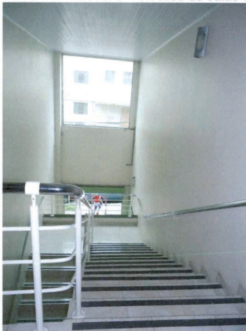
FOTO 15 – Imóvel 8 – Acesso as salas comerciais
