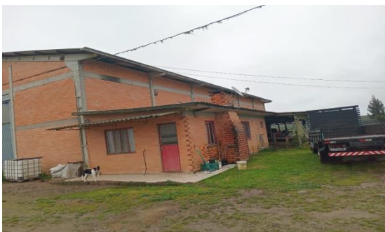
Vista parcial Galpão Industrial.
