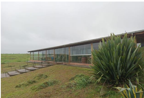
Residência do proprietário.
