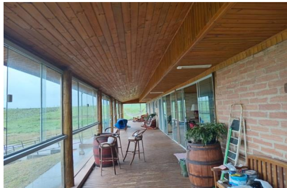
Vista parcial interior da residência.
