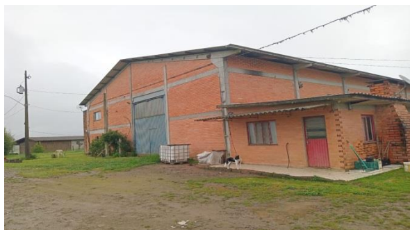
Fachada Galpão Industrial.
