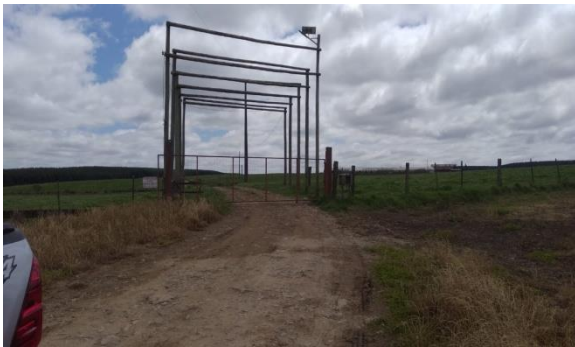
Acesso principal para a propriedade.
