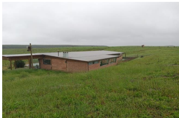
Vista parcial da residência.
