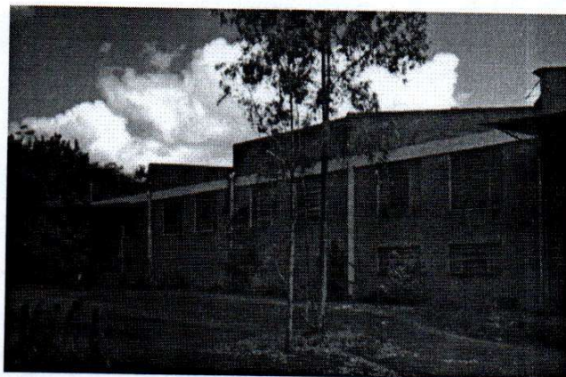
Vista Externa do Pavilhão da Unidade Industrial da CYCIAN
