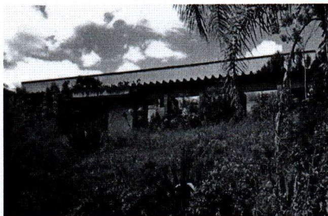
Vista Externa do Prédio Administrativo da Unidade Industrial da CYCIAN
