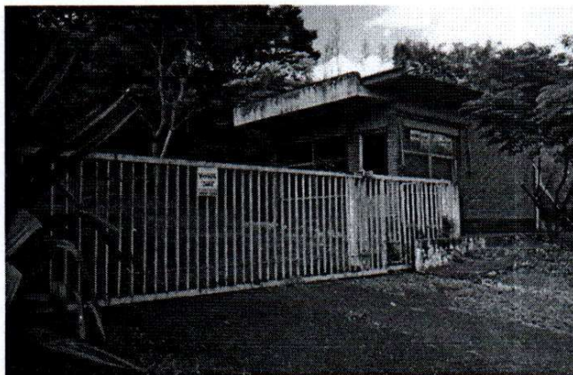
Vista da Guarita de Entrada na Unidade Industrial da CYCIAN
